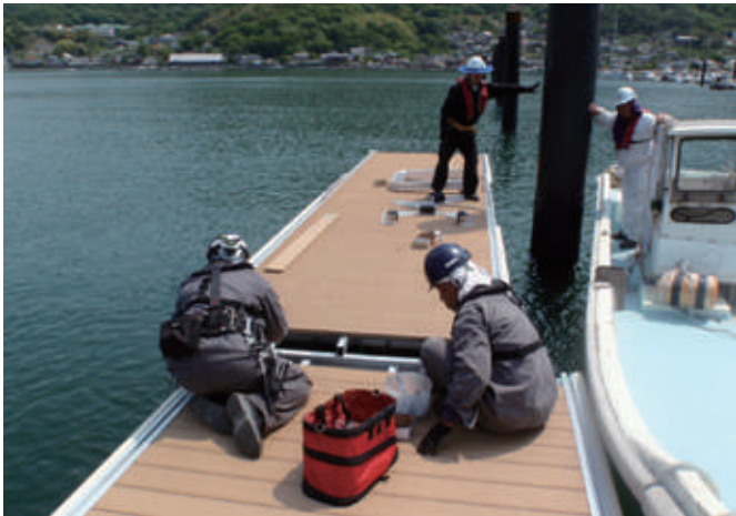
建設当時の様子（浮棧橋の組み立て～設置）
